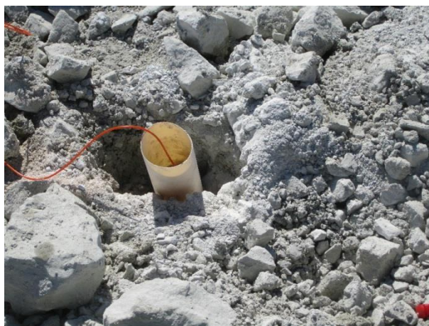
Figura 2 – Testa – foro con cartuccia inserita. Il tubicino rosso è del sistema di innesco non elettrico
